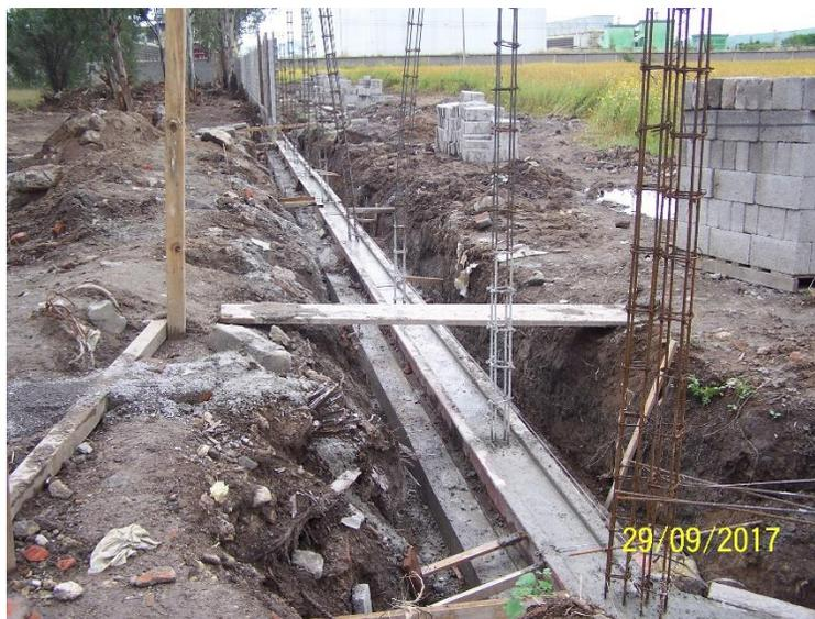
Figura 47. Construcción de barda
