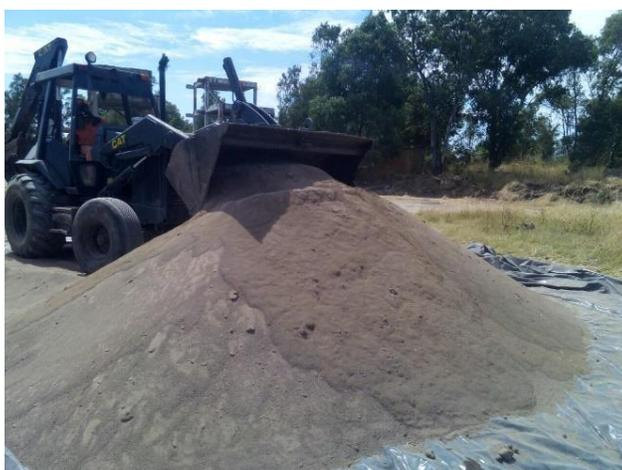
Figura 31. Homogenizado del suelo fino.
