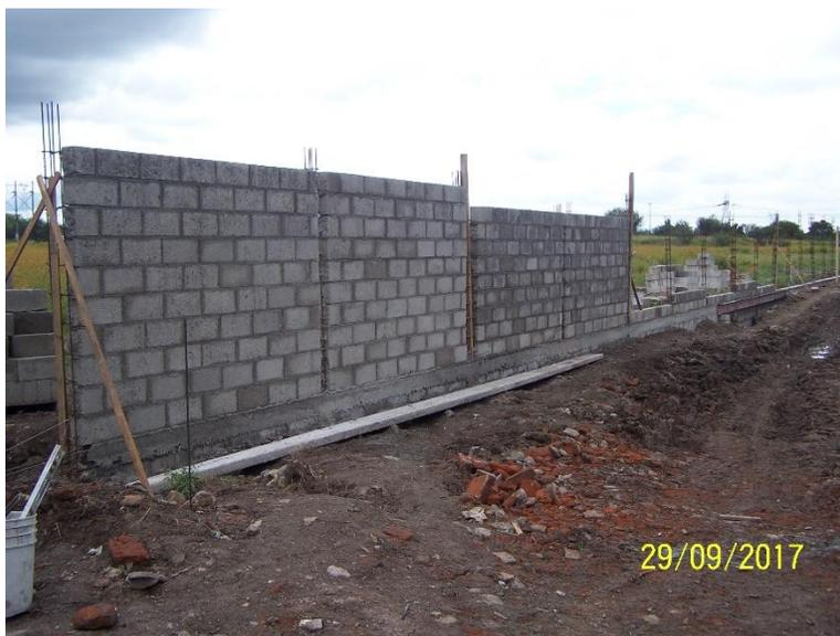
Figura 48. Construcción de barda
