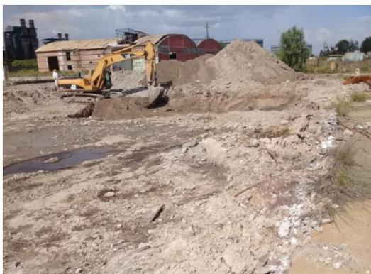
Figura 60. Excavación de suelo contaminado con mercurio.
