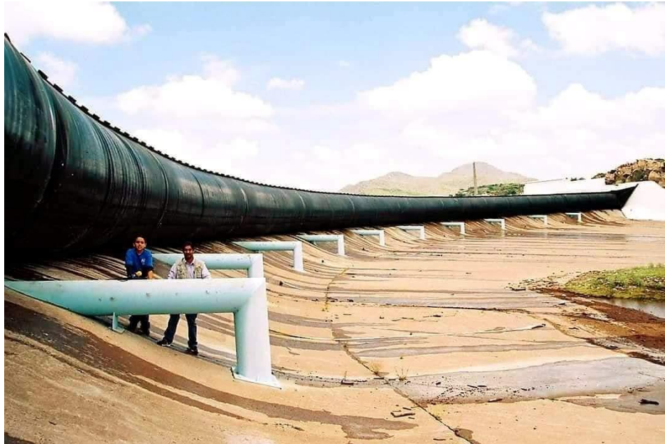
Figura 4. Trabajos de rehabilitación de la Presa Francisco I. Madero (Las Vírgenes), Chih.
