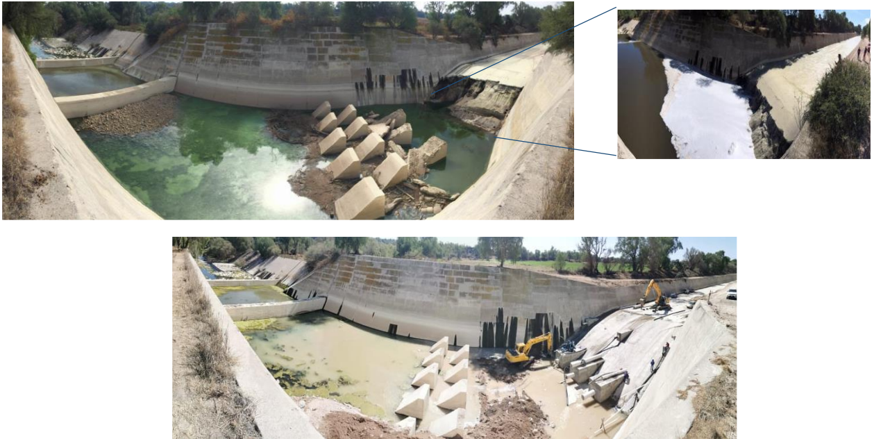
Figura 3. Trabajos de rehabilitación de la Presa Endhó, Hgo.
