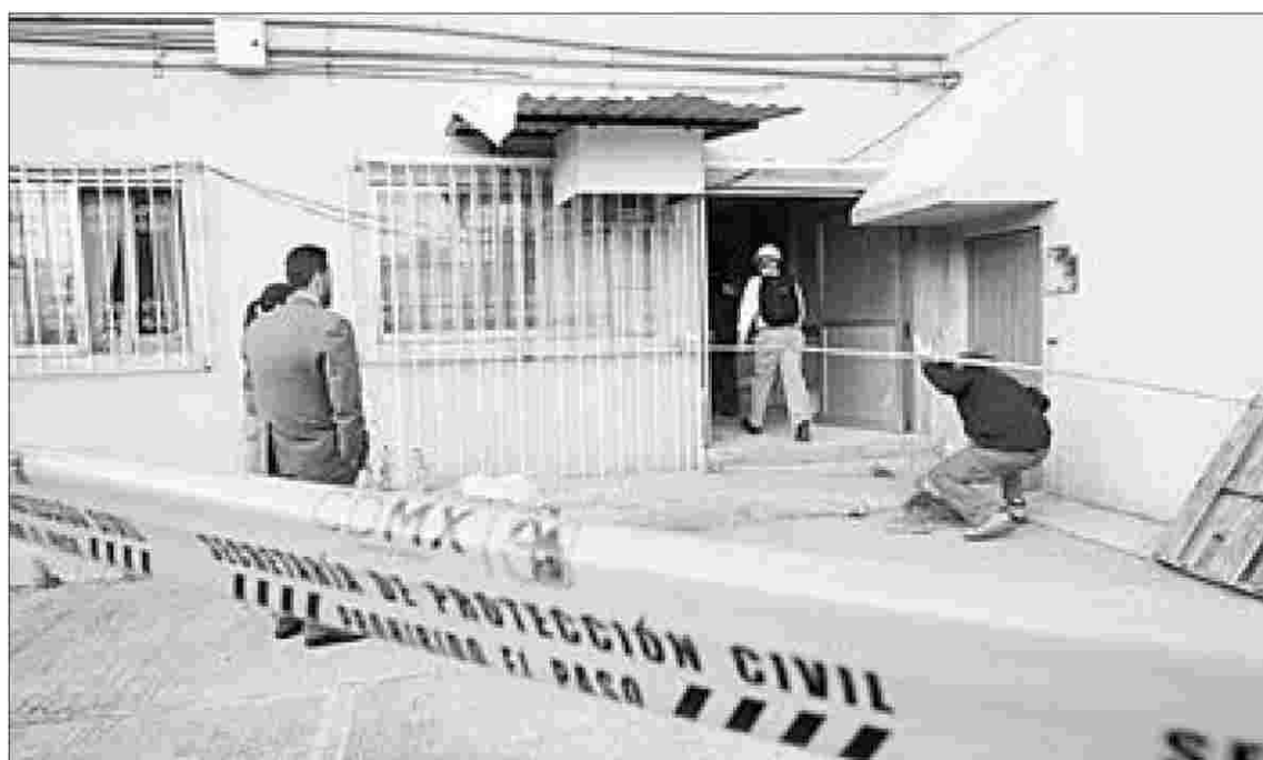
► En el inmueble ubicado en la calle 16 de Septiembre, del pueblo de San Martín Xochinahuac, Azcapotzalco, fue encontrado un túnel con tomas clandestinas en cinco ductos de Pemex. Foto Yazmín Ortega Cortés
