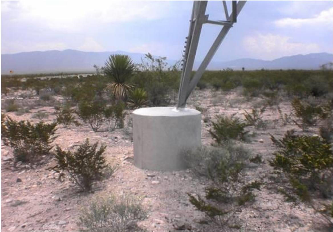
Foto I-23 Ejemplo de una cimentación de concreto para las torres de transmisión.
