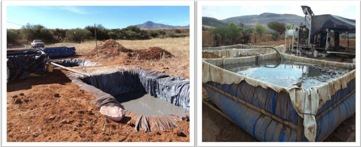
**Figura II.11. Cárcamos para recirculación del fluido de perforación
