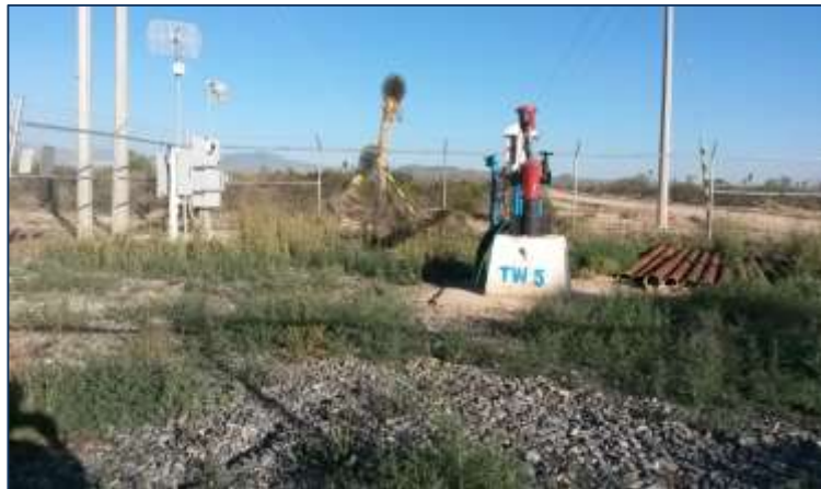
Condiciones actuales de las plataformas de pozos
