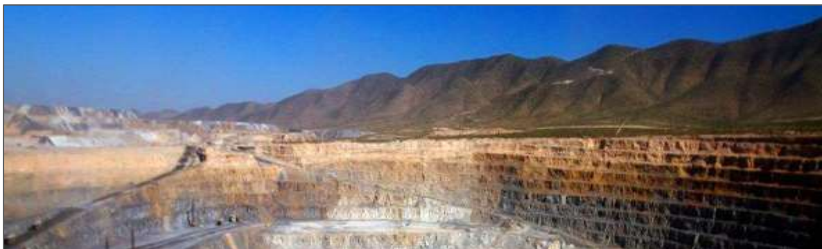
Imagen 2. Infraestructura de Minera Peñasquito
