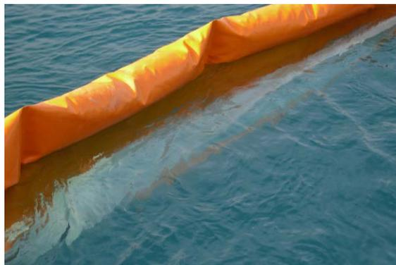
Barreras antiturbidez de flotación sólida dotada de una cortina geotextil, compuesta por una barrera flotante de contención y una cortina antiturbidez inferior.
