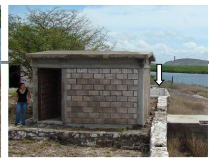
Se colaran paredes nuevas de concreto reforzado con varilla de acero con un espesor de 10cm y con un  $F'c=200\text{Kg/cm}^2$ . Las paredes serán recubiertas en su cara interior con azulejo vidriado de la región, obteniendo un sellado definitivo. Además se instalarán los sistemas necesarios la recirculación del agua.
