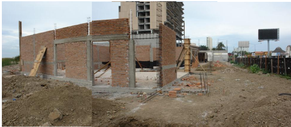
Bodega existente y al lado izquierdo construcción realizada.
