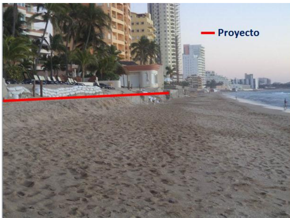
Figura II.3. Vista del sitio del proyecto.
