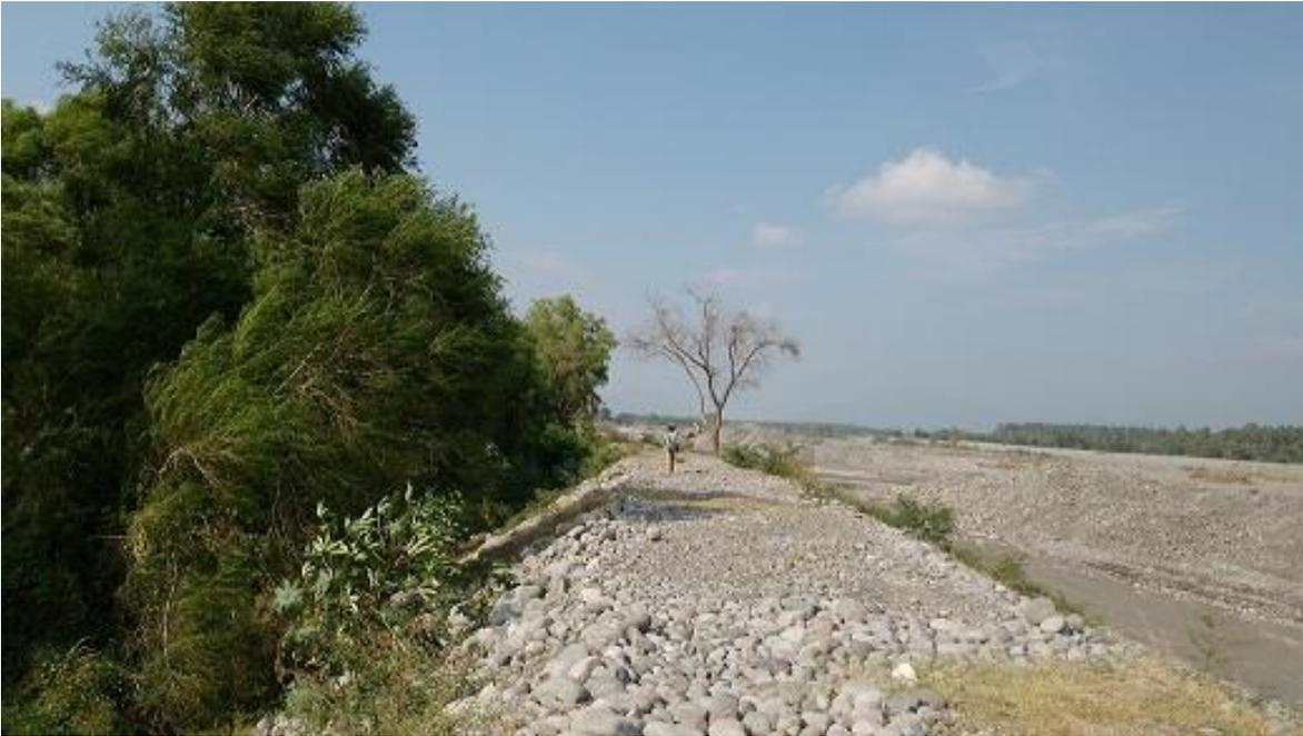
*Imagen rio abajo, solo para mostrar cómo deben acondicionarse los taludes para estabilizar la zona federal.*
