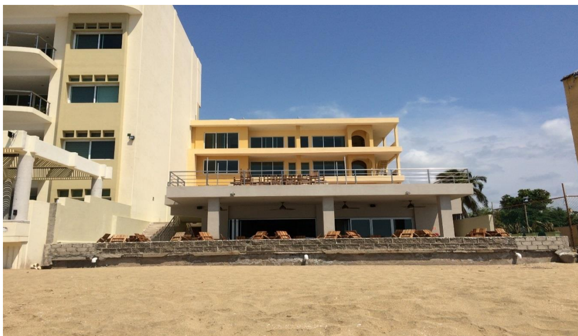
Vista del área rehabilitada
