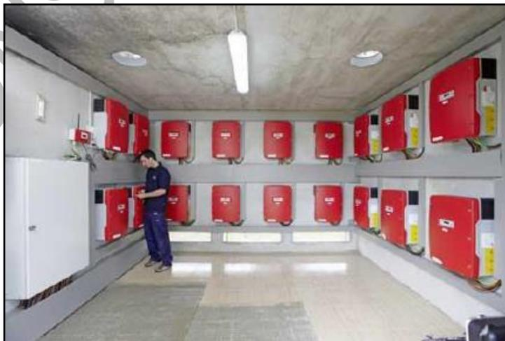
**Figura II.6.** Ejemplo de instalación de inversores distribuidos.
