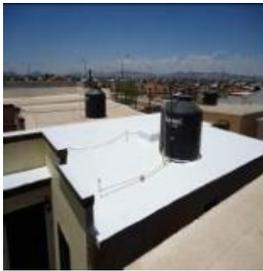
3.- Recubrimiento reflectivo en las azoteas de las viviendas como acabado final, que atenúan la carga térmica en el techo.
