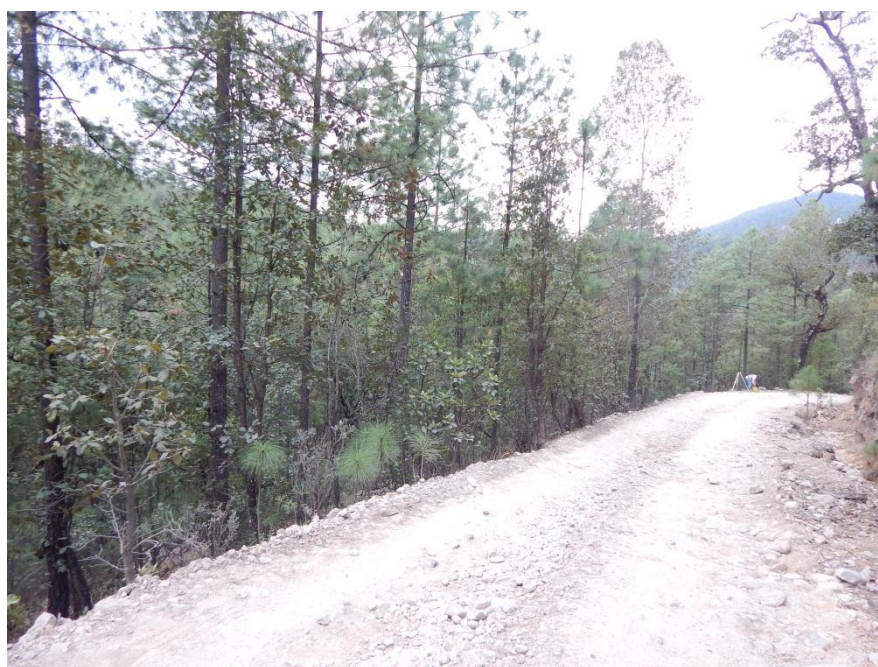
Figura 34. Camino existente donde se pretende realizar la obra.
