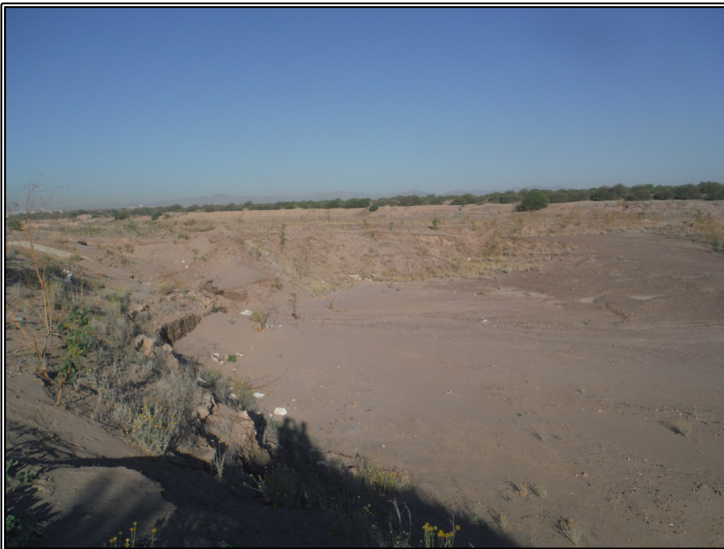
Foto VIII.1.2.5 Vista de Noreste a Suroeste del área de extracción.
