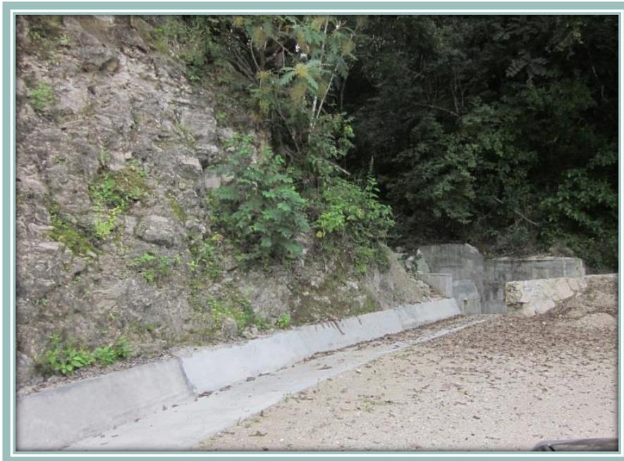
Figura VI.7. Drenes pluviales reducen el grado de erosión
