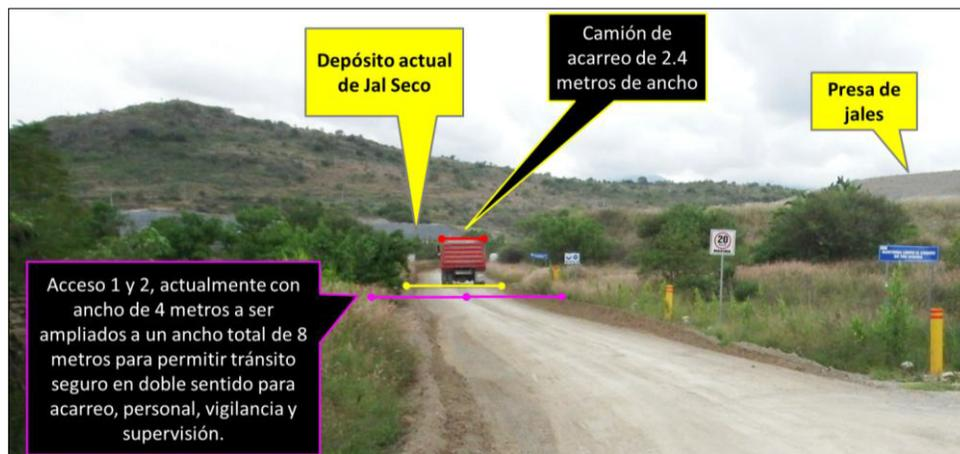
**Figura 2. 13. Ampliación de accesos existentes**
