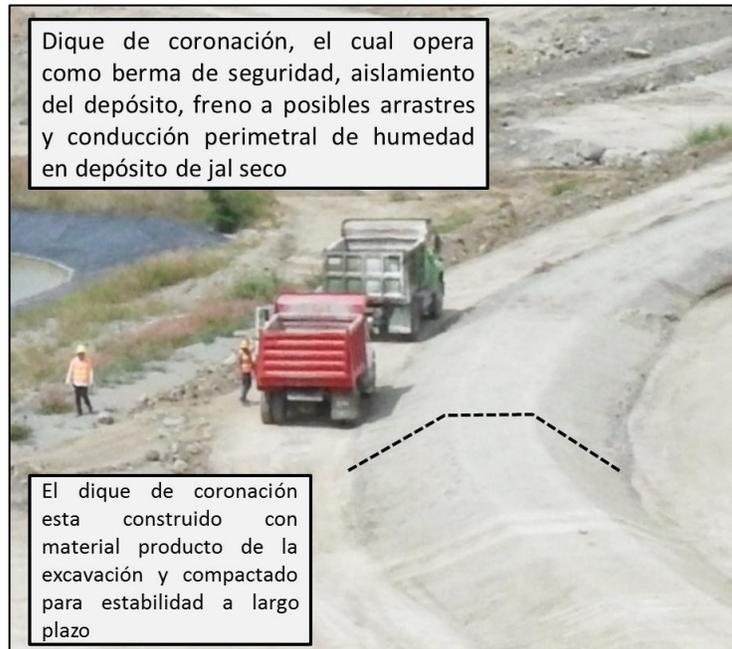
**Figura 2. 10. Ejemplo de berma o dique perimetral del actual depósito de jal seco**
