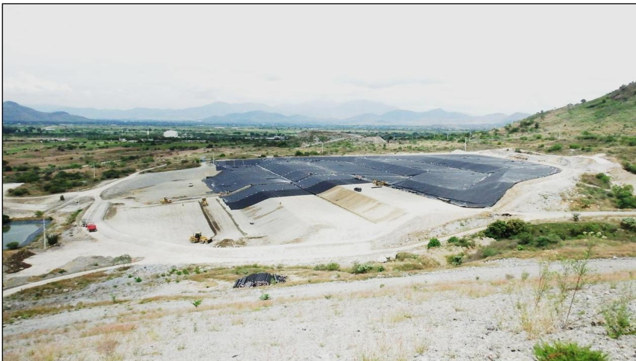
**Figura 2. 8. Ejemplo de instalación y conformación del depósito de jal (área aprobada MIA según Figura 2.5)**
