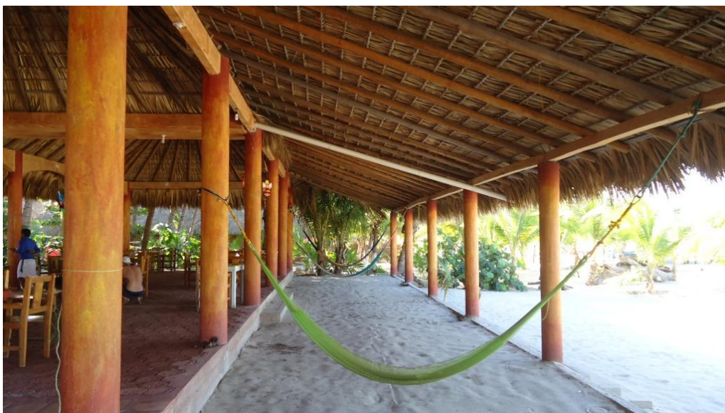
Figura II.7. Corredor aledaño a la palapa principal.
