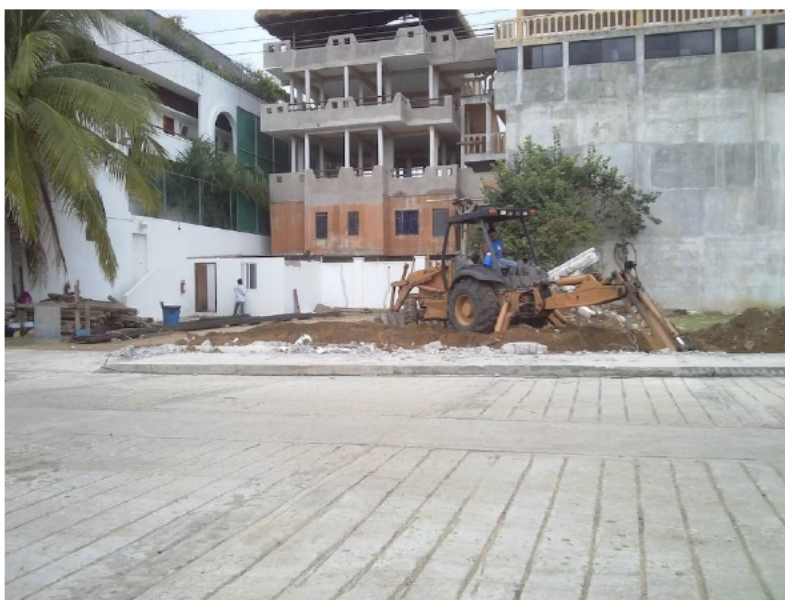
Imagen 5 En una fotografía tomada al inicio de los trabajos (Derribo de barda perimetral), se aprecia el terreno plano en el que se encuentra actualmente el proyecto.
