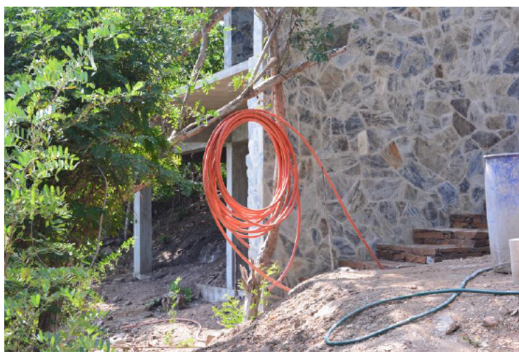
Figura II.9 Vista actual de las escaleras en construcción
