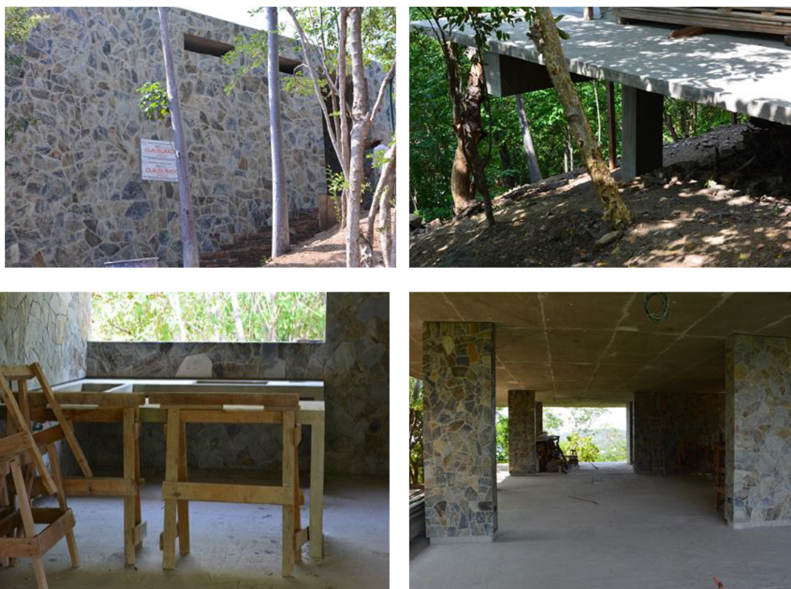
Figura II.7 Vista actual del avance de la construcción de la villa.
