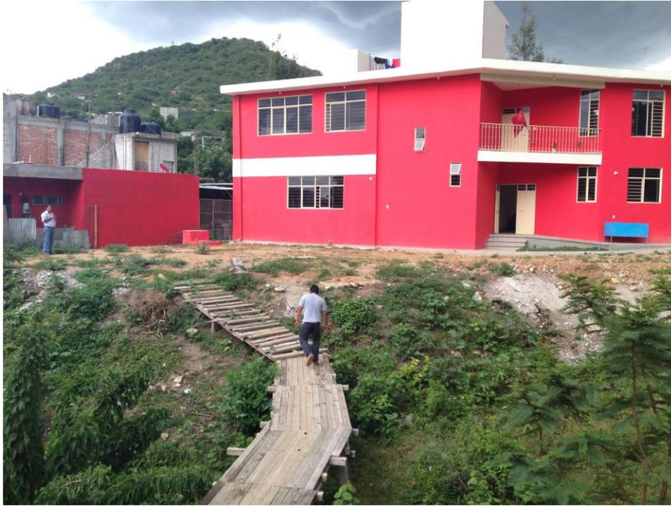
Figura 3. Actual puente peatonal a base de madera vista desde en circuito Norte Oriente, hacia el Circuito 2.
