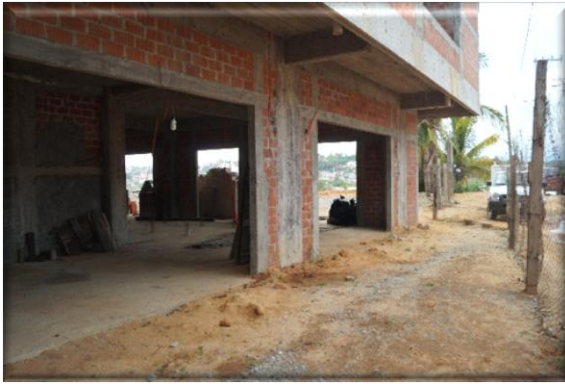
Imagen II. 3 Vista de las entradas a la recepción del edificio
