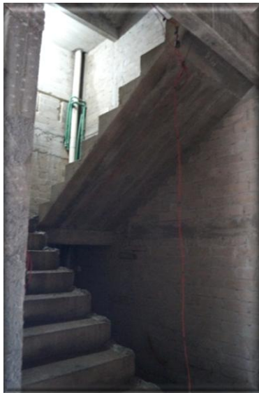
Imagen II. 9 Escaleras de cemento y tabicón
