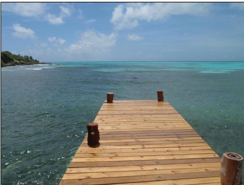
Imagen ejemplo donde se observa que algunos pilotes de madera se prolongan para crear las bitas de amarre.
