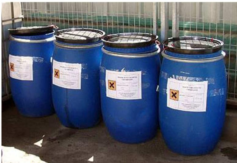
**Figura 53.-** Ejemplo de botes y señalización tipo a utilizar en la etapa operativa del proyecto para el confinamiento temporal de residuos que por su naturaleza se consideren como peligrosos.
