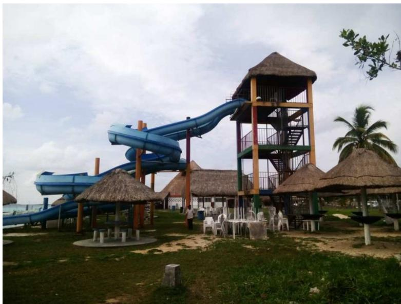
8.- Una palapa construida con madera de la región techo de zacate, piso de cemento y paredes descubiertas en una superficie de 32 metros cuadrados (8 metros de longitud por 4 metros de ancho).
