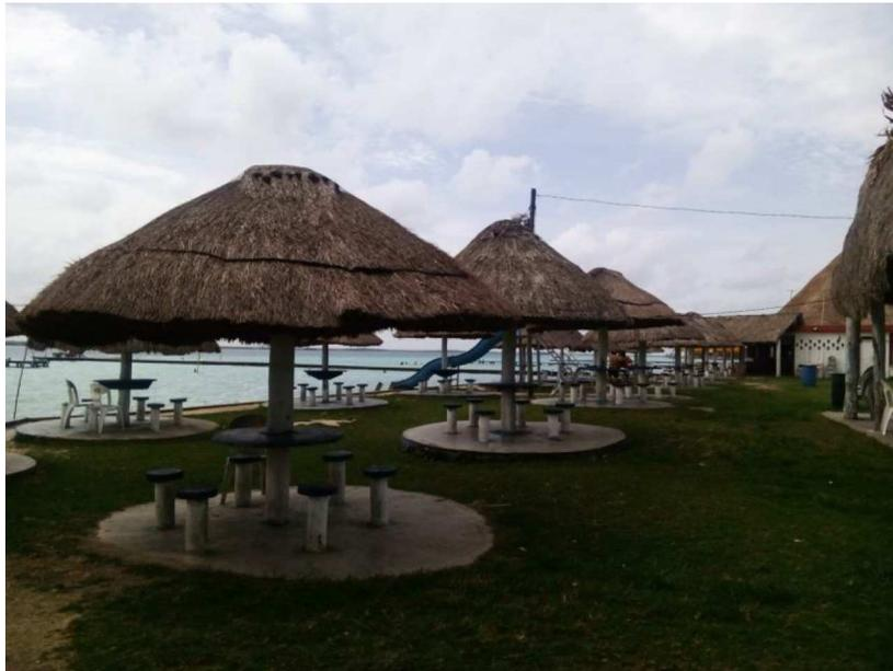
**5.-** Una palapa restaurante circular, construida con madera de la región techo de zacate, paredes descubiertas y piso de cemento en un diámetro de 20 metros, donde se ubica el área de comensales. Cuenta con un anexo construido con material de cemento, block y losa en una superficie de 240 metros cuadrados (30 metros de longitud por 8 metros de ancho), en donde se ubica la cocina, oficinas y tiendas de ventas de artesanías.
