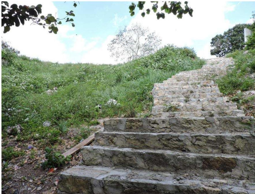
Figura 3.- Otra vista de la escalinata de mampostería construida en el predio.
