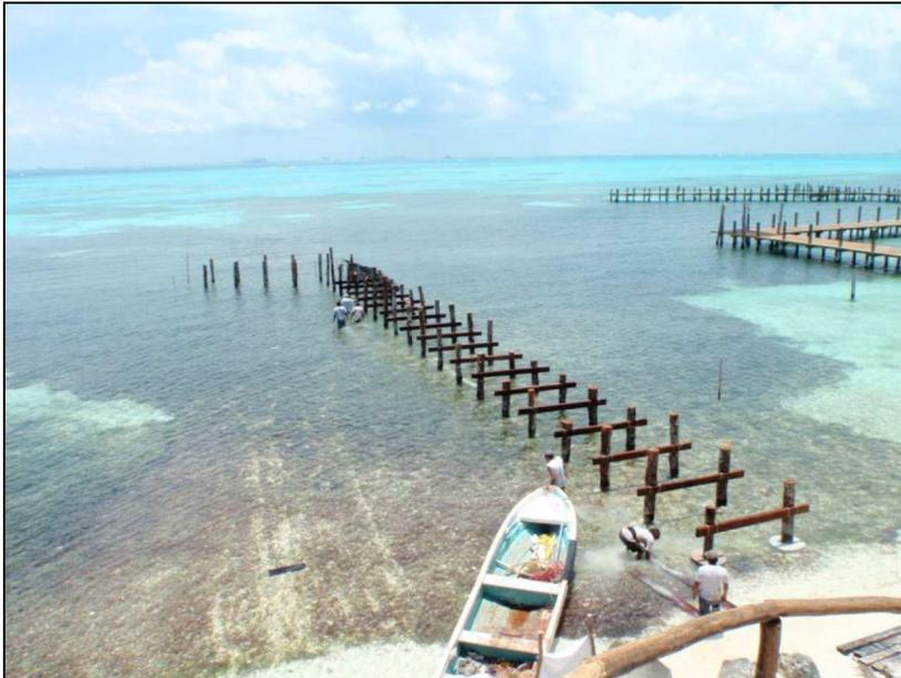
Esta es una imagen ejemplo, de la construcción del embarcadero, se observa que los pilotes ya fueron hincados.
