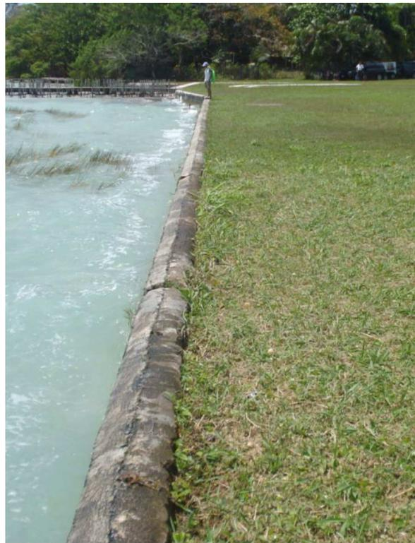
Fotografía 2. Muro de contención
