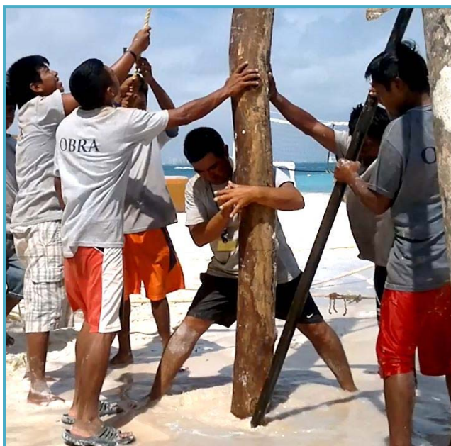
Figura II_ 37. Proceso de chifoneo y colocación de los pilotes de soporte.
