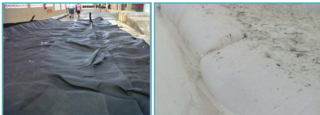
Figura II_29. Saco de geotextil vacío y ejemplo de elemento de geotextil temporal de apoyo.
