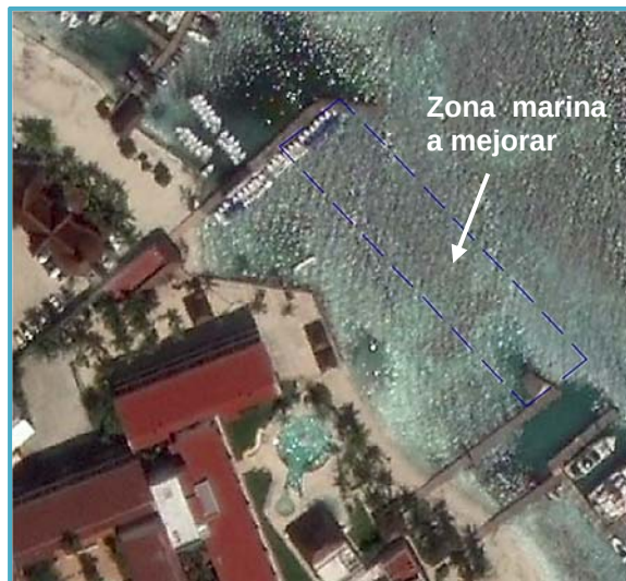
Figura II_ 10. Zona marina a mejorar.
