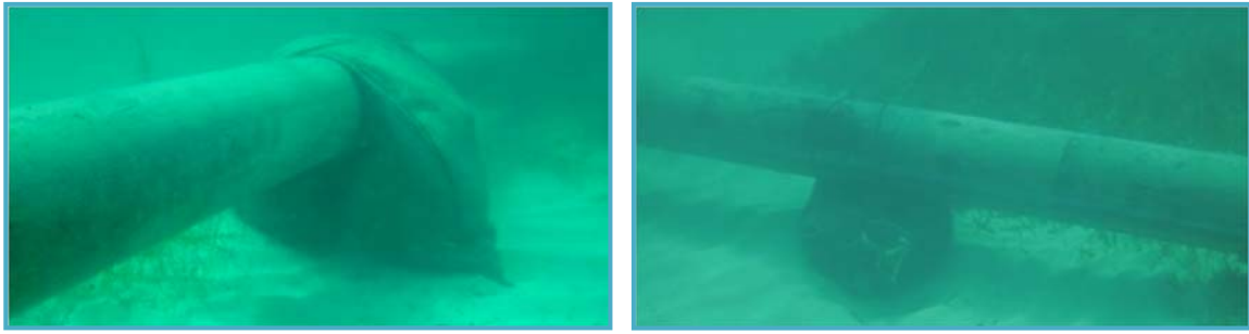
Figura II_ 40. Tuberías y mangueras con lastre de proyectos similares.
