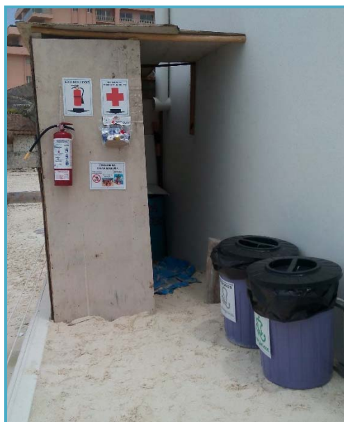
Figura II_ 28. Ejemplo de bodega provisional y contenedores para basura.
