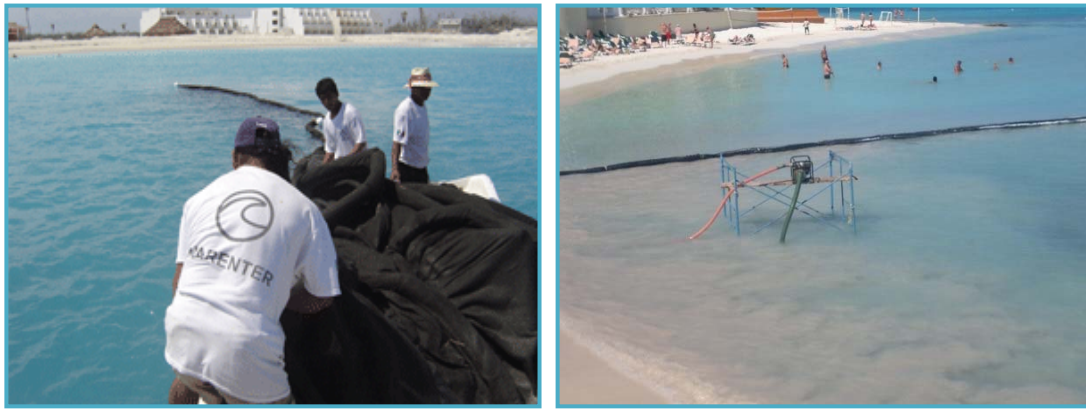
Figura II_ 41. Colocación y funcionamiento de malla antidispersión, en proyectos similares.
