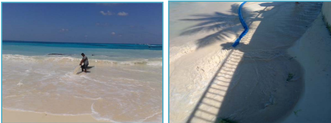
Figura II_ 42. Manguera de descarga de arena sobre la playa.
