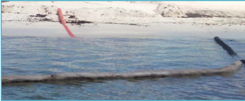
Figura II_ 28. Descarga de arena sobre la playa.
