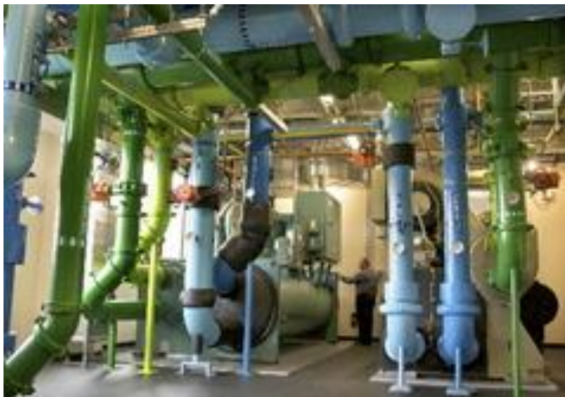
Imagen II-18. Sistema de distribución de aire acondicionado.
