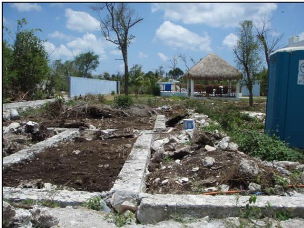
Una vez construidos los cimientos de mampostería se procederá a rellenar las áreas interiores con el material producto de la excavación de los cimientos, complementándolo con material de banco (sascab), proveniente de bancos autorizados.
