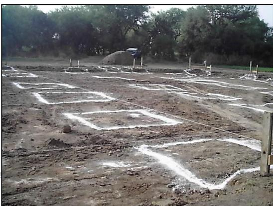
Una vez realizado el trazo, se marcará con cal el lugar exacto donde se realizara la excavación lineal para el alojamiento de la cimentación y para el área donde se construirá la cisterna seca impermeabilizada así como el campo de infiltración.
