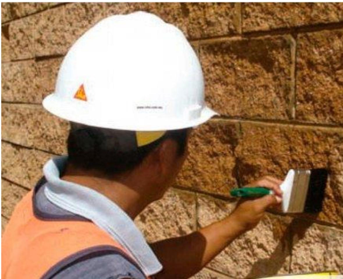
Una de las funciones es evitar que la mampostería absorba mucha pintura, para evitar gastos innecesarios con capas adicionales de pintura. [Pintar una pared](#) sin preparación puede hacer que pierda mucha pintura y el resultado final puede verse perjudicado.
