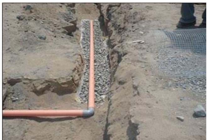
Vista de las tuberías en la zanja de infiltración.
