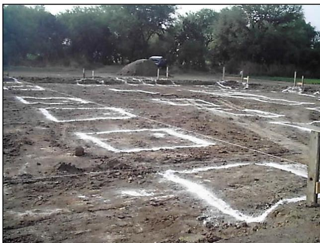
Una vez realizado el trazo, se marcará con cal el lugar exacto donde se realizara la excavación lineal para el alojamiento de la cimentación de la casa residencial y para el área donde se construirá la cisterna seca de hormigón impermeabilizada.
