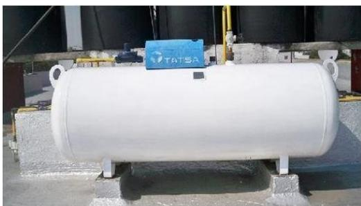
Básicamente se utilizará como combustible solo el gas butano de uso doméstico, que servirá para el funcionamiento de la cocina. Se utilizará un tanque estacionario de 1,100 litros de capacidad, mismo que será abastecido periódicamente por la empresa Z Gas.
