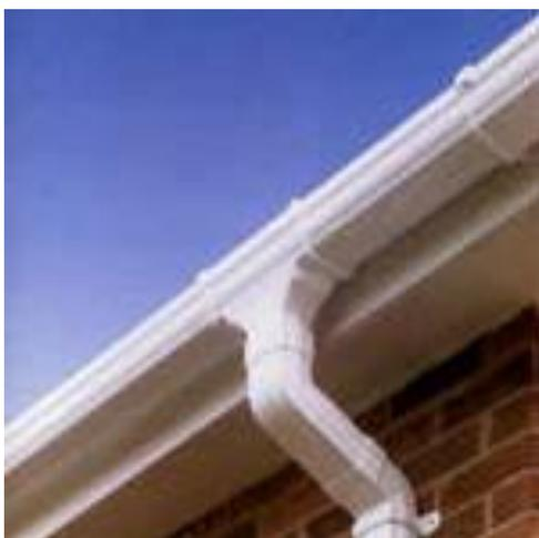
El material de las canaletas debe ser liviano, resistente al agua y fácil de unir entre sí, a fin de reducir las fugas de agua.
