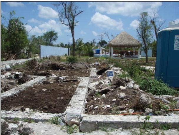
Una vez construidos los cimientos de mampostería se procederá a rellenar las áreas interiores con el material producto de la excavación de los cimientos y de la cisterna seca impermeabilizada de hormigon, complementándolo con material de banco (sascab), proveniente de bancos autorizados.
