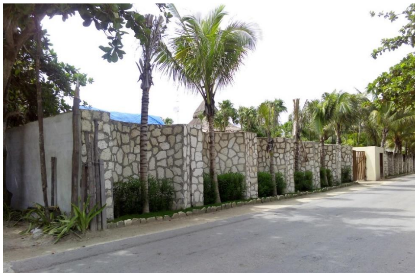
Foto 3.- Vista parcial de la barda perimetral del predio.
