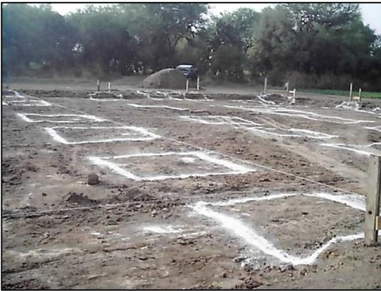
Una vez realizado el trazo, se marcará con cal el lugar exacto donde se realizara la excavación lineal para el alojamiento de la cimentación lineal, de las zapatas, columnas y la cisterna de almacenamiento del agua potable.
