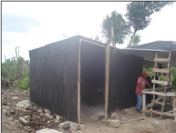
Se construirá una bodega provisional de lámina de cartón empetrolado para el resguardo de herramientas y materiales que se utilizarán en las etapas de preparación del sitio y construcción. Las dimensiones de la bodega serán de 5 x 5 metros con un tinglado. La bodega se construirá dentro del predio. Esta obra será solo temporal y se retirará al término de los trabajos de construcción.
