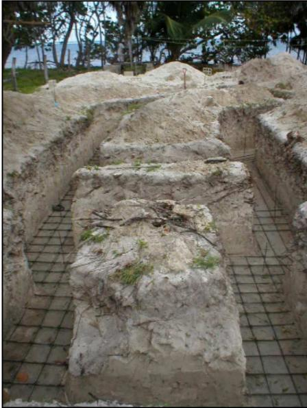
Al inicio de las actividades de construcción, se procederá a excavar por medios manuales (pico y pala) y mecánicos (Excavadora) en las zonas donde se construirán los cimientos de mampostería, y los anclajes de la estructura del edificio de las residencias (dados y zapatas de concreto armado). Para la cimentación se harán excavaciones de .30 m de ancho por .50 m de profundidad o hasta que se tope con laja (roca).
