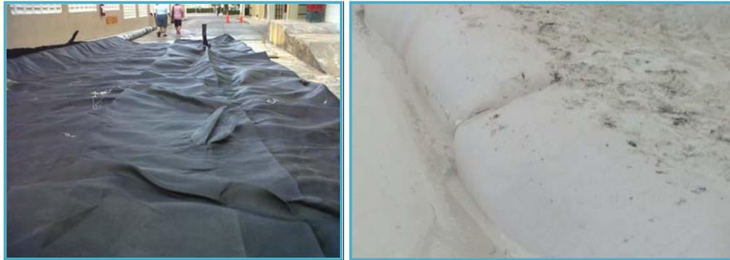
Figura II\_29. Saco de geotextil vacío y ejemplo de elemento de geotextil temporal de apoyo.
