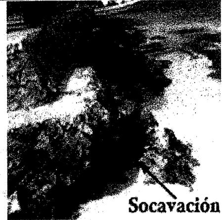
De acuerdo con la información proporcionada, se tiene que el oleaje se encuentra incidiendo directamente con las construcciones del predio contiguo, por lo que las estructuras presentan daños y socavaciones.
