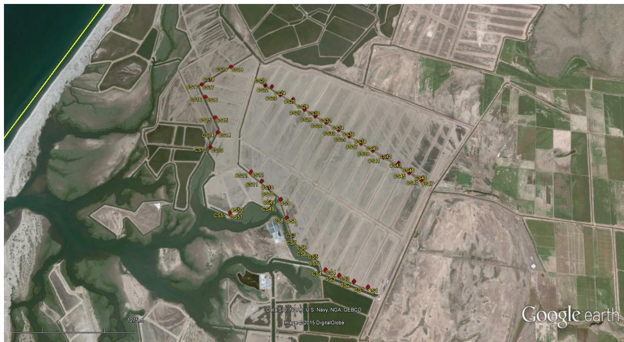
Figura 11. Distribución de Compuertas de salida a lo largo de la estanqueras de Acuícola San Martín, generalmente una por cada estanque (interior, en estanque; exterior, canal de salida) se incluyen compuertas en reservorios.
