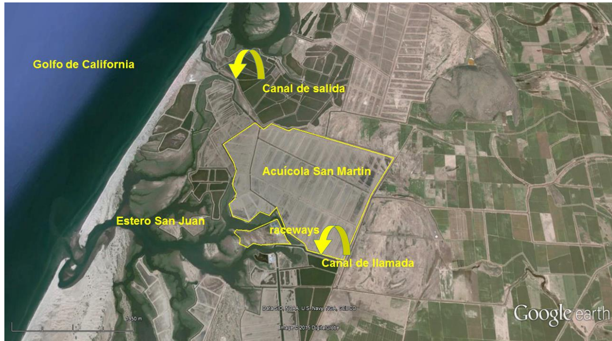
Figura 03. Panorámica del Sistema Ambiental cercano al sitio del Proyecto con la presencia de canales; de abastecimiento de agua de 1.23 km de longitud que conecta al Estero San Juan y del canal colector de aguas usadas con una longitud de 2.5 km misma distancia que puede actuar como un canal de oxidación de la materia orgánica, ya que existe una precipitación a lo largo del camino y las bacterias y demás organismos acuáticos descomponen la materia reduciendo además las aguas del Golfo de California son ms dinámicas que los sistemas estuarinos, por lo que no se producirá una eutrofización del Sistema marino en el Golfo de California
