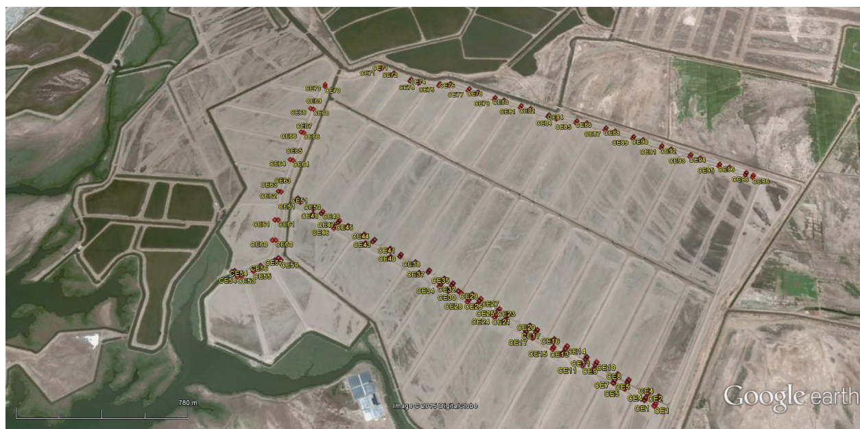
Figura 10. Distribución de Compuertas de entrada a lo largo de la estanqueras de Acuícola San Martin, son dos por cada estanque (interior, en estanque; exterior en reservorio) se incluyen compuertas en reservorios.
