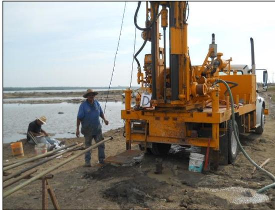
Las perforaciones fueron ejecutadas con máquina rotatoria mediante el empleo de ademes helicoidales, como técnica de avance, se complementó con lavado con lodos bentoníticos y herramienta tricónica.
