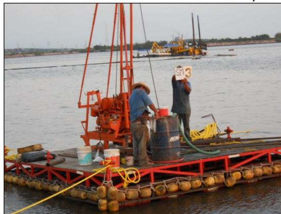
En la ejecución de los sondeos, las pruebas de penetración estándar se llevaron a cabo conforme la norma ASTM D-1586. En éstas pruebas se recuperaron muestras alteradas y se determinaron a la
