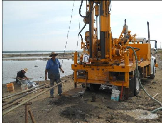
Las perforaciones fueron ejecutadas con máquina rotatoria mediante el empleo de ademes helicoidales, como técnica de avance, se complementó con lavado con lodos bentoníticos y herramienta tricónica.
