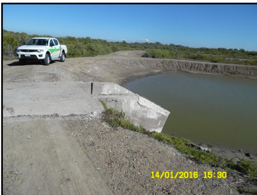
**Figura II.2.** Estructuras de alimentación y bordos erosionados
