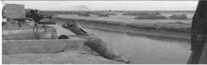
**VEASE CONSTRUIDO EL UNO DE LOS DOS CARCAMOS DE BOMBEO CON SU RESPECTIVA BOMBA AXIAL Y MOTOR DE COMBUSTIÓN INTERNA QUE TIENE CADA CARCAMO DE BOMBEO EMPOTRADO SOBRE PLANCHA DE CONCRETO ARMADO Y BLOCK DE CONCRETO PREFABRICADO CON SU DIQUE DE CONTENCIÓN PARA EN CASO DE DERRAMES DE HIDROCARBUROS O GRASAS Y ACEITES LUBRICANTES..**
