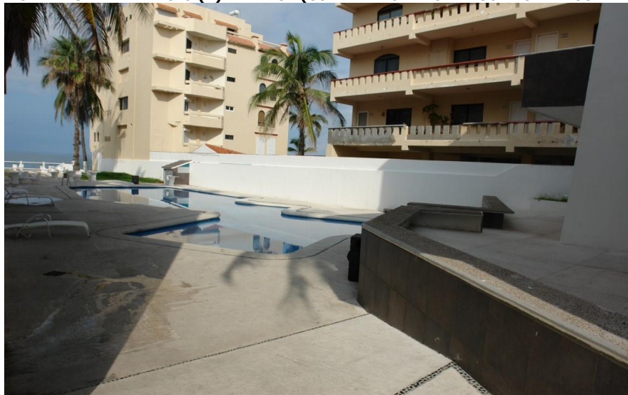
VISTA INTERIOR EDIFICIO (A) Y ALBERCA
