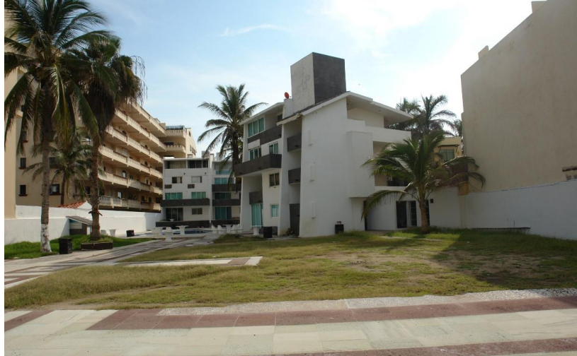
VISTA DESDE MURO DE CONTENCIÓN AL ESTE ÁREA COMÚN RECREACIÓN, AL FONDO EDIFICIO B Y DERECHA EDIFICIO A.
