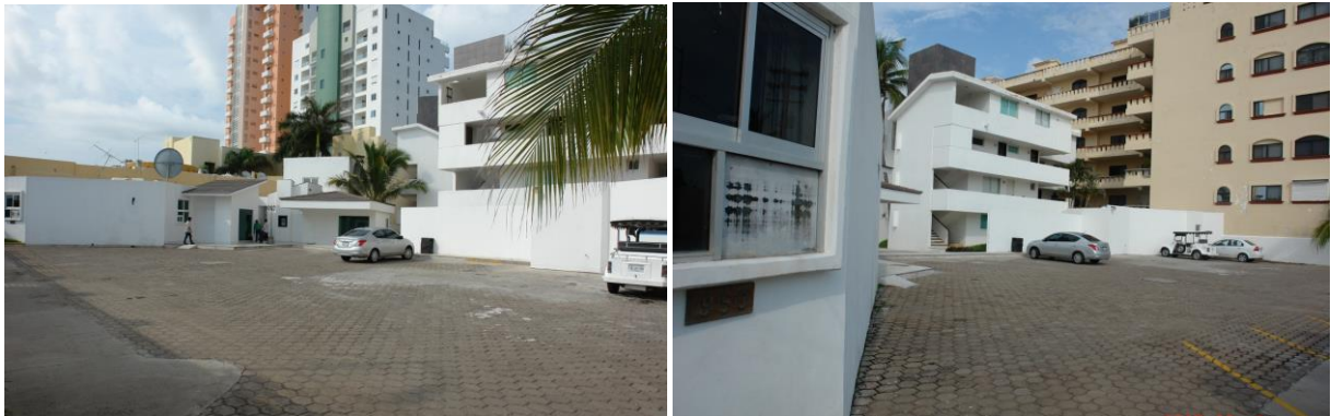
VISTA ADENTRO ATRÁS DEL EDIFICIO (B) ALBERCA (COLINDANCIA NORTE CONDOMINIOS MARINA DEL REY.
