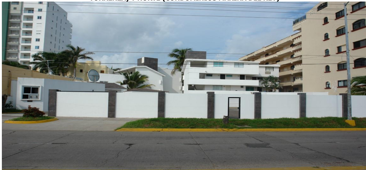
VISTA AL ACCESO AV. SÁBALO CERRITOS S/N, PARTE ESTE DEL PROYECTO Y COLINDANCIAS SUR (EDIFICIO TORRENZA) Y NORTE (CONDOMINIOS MARINA DEL REY)
