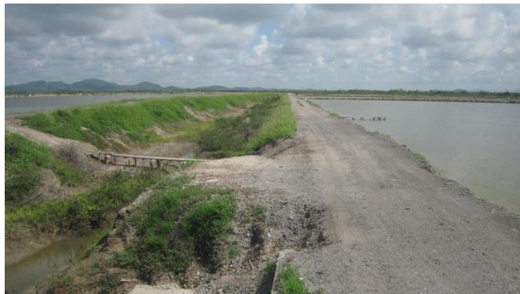
La bordería presenta taludes erosionados, por la inevitable acción conjunta del agua y el viento.
