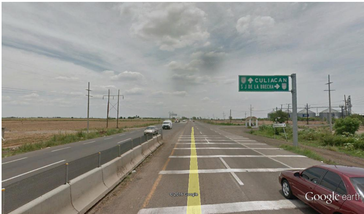
Carretera México 15 e intersección con carretera SIN-218 a San José de la brecha.
