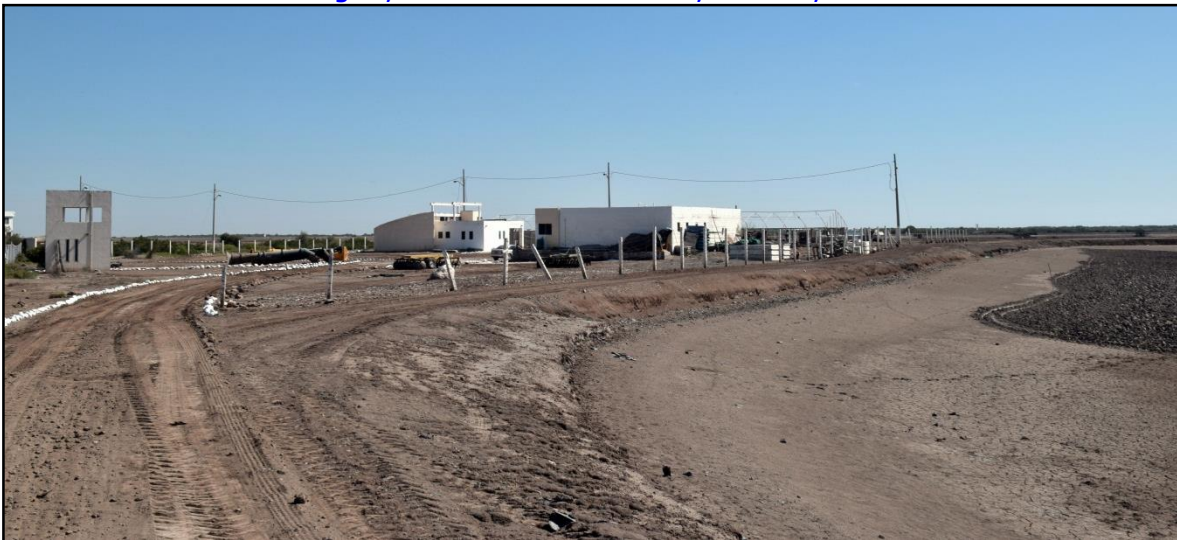
Vista actual de las instalaciones, área de oficina, caseta de vigilancia y almacén. (Febrero de 2016).
