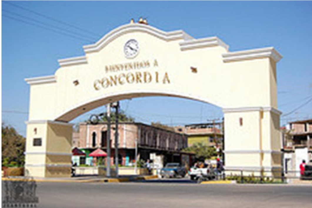
Figura IV. 18.- Entrada a cabecera municipal, Concordia.
