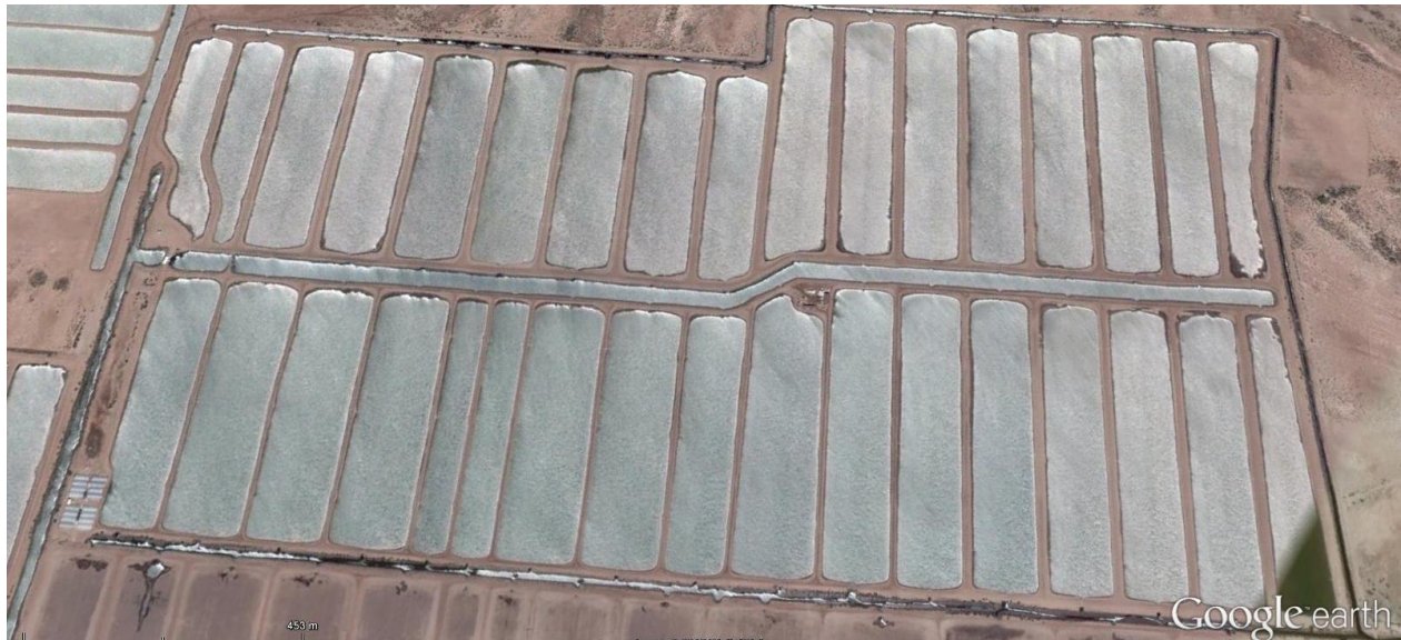
Figura 07. Infraestructura actual de granja acuícola SINMAR al centro se observa el canal reservorio con el acomodo de 17 estanques a cada lado, con un total de 34 estanques, canales de aguas usadas en la periferia y el canal de llamada que abastece el reservorio con presencia de un campamento en el centro de la granja y un módulo existente de pre-cría denominada "RACEWAY".
