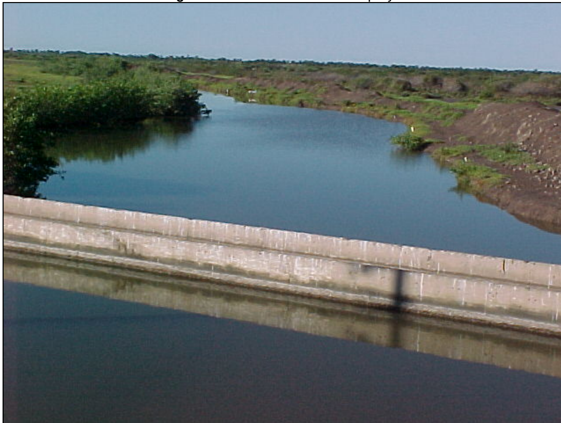
Fotografía 4. Canal de llamada del proyecto.
