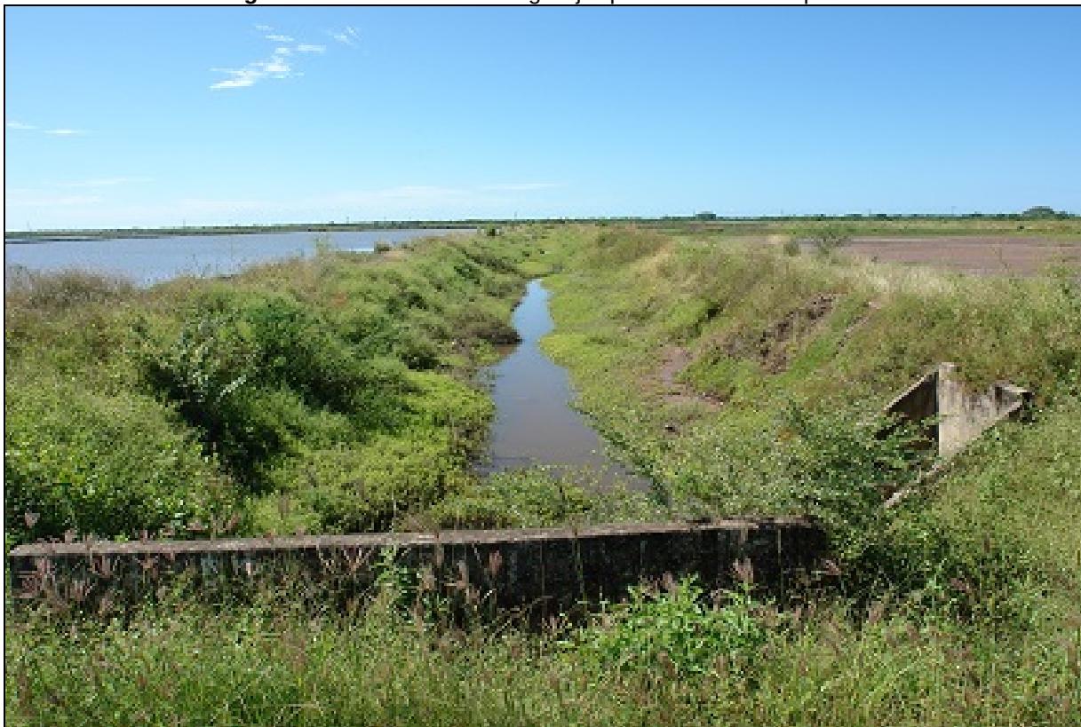
Fotografía 1. Canal dren de la granja que se encuentra operando.
