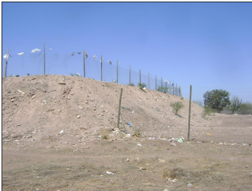
Foto No. 22 - Cerco perimetral y malla ciclónica
