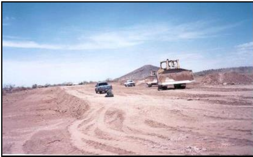
Foto No. 5 - Inicio de la construcción de la bordería de la celda
