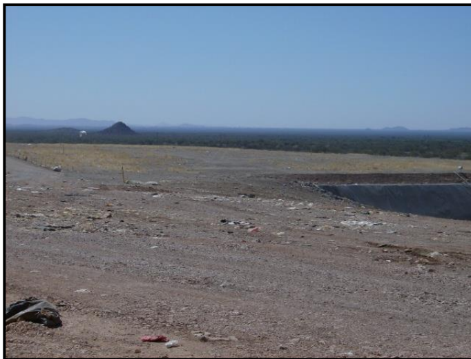
Foto No. 17. Operación terminada
