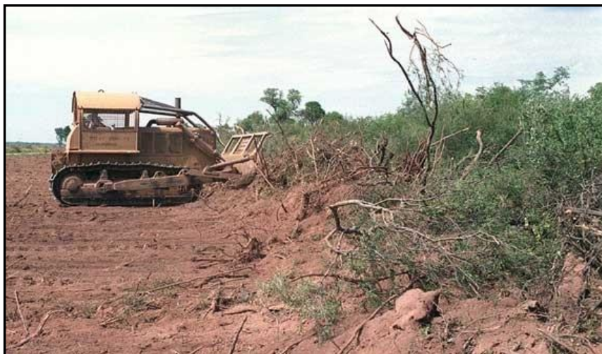
Foto No 4. Maquinaria para desmonte
