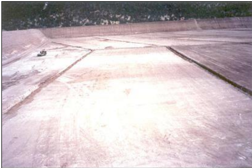
Foto No. 9 - Instalando el drenaje de lixiviados
