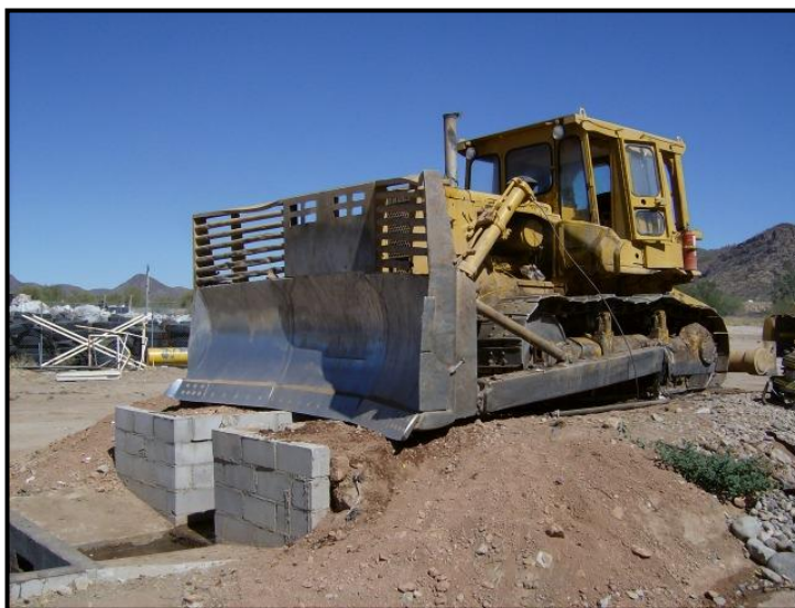
Foto No. 21 - Fosa de reparación mecánica
