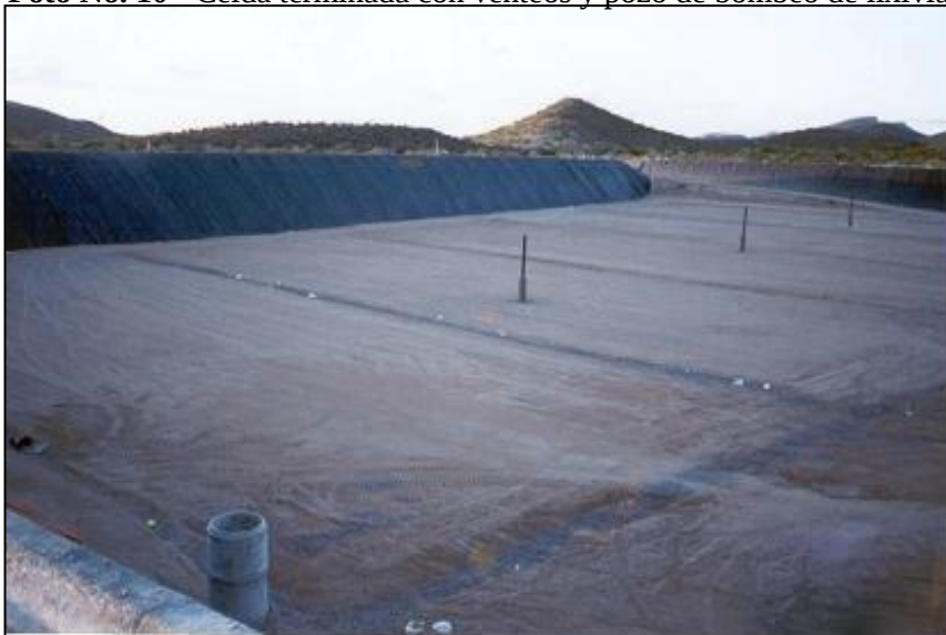
Foto No. 10 - Celda terminada con venteos y pozo de bombeo de lixiviados
