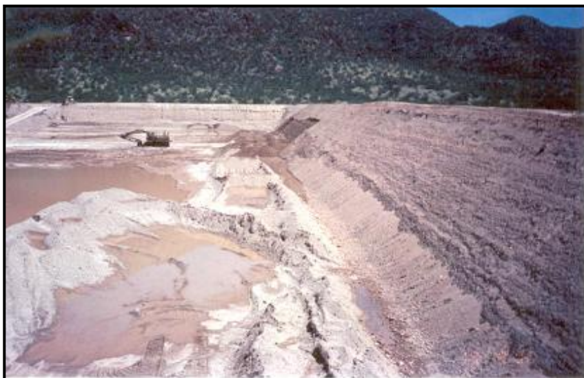
Foto No. 6 – Excavación y bordería perimetral terminada
