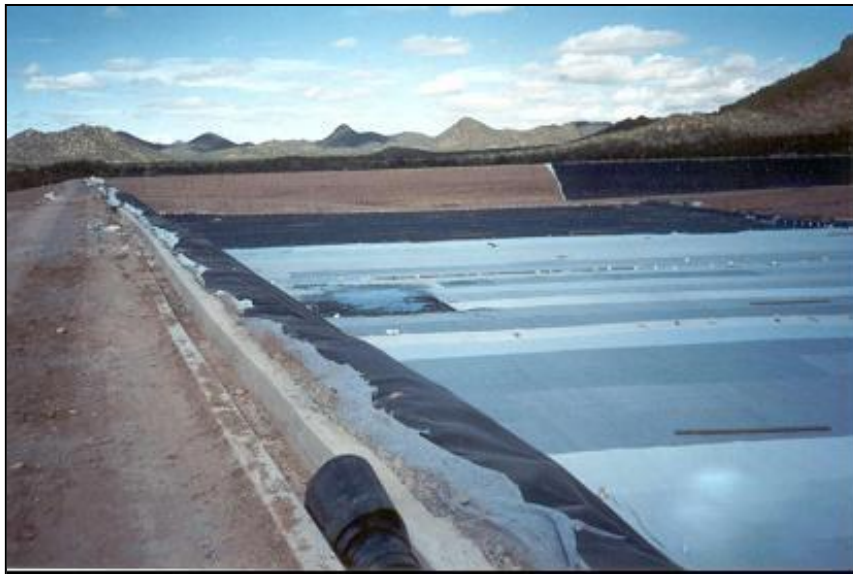
Foto No. 8 – Sellado sintético de la celda
