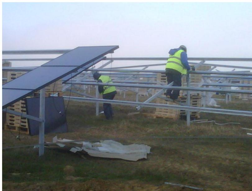
*Imagen 9 Proceso de instalación de los paneles solares en estructura metálica*
